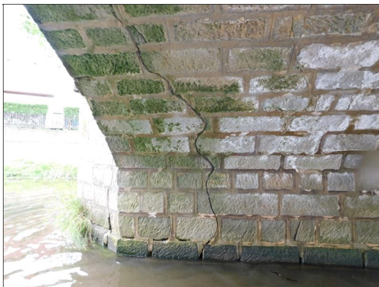
Široká trhlina na pravé straně pilíře P3 ve vzdálenosti cca 1,0 m od pravého kraje.
