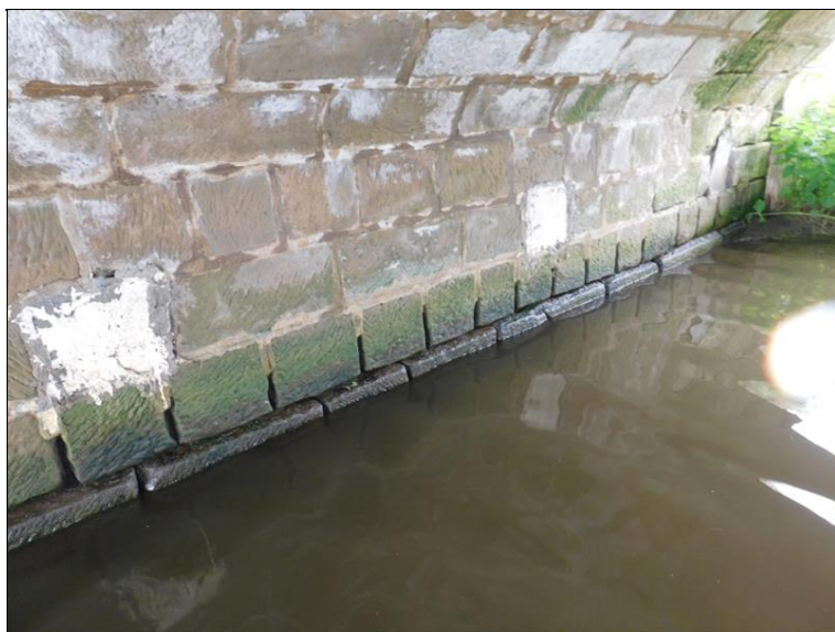
Hlubkově vyplavené spárování v patě opěry OP3 v úrovni kolísání hladiny vodního toku.
