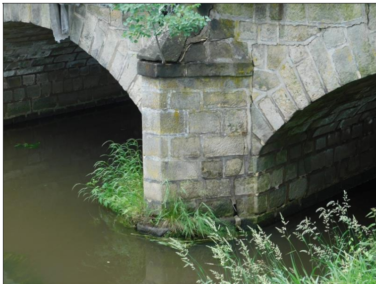
Pohled na pravý bok pilíře P3, do pole 3 patrná svislá trhlina. V horním části pilíře uchycena vegetace (strom).
