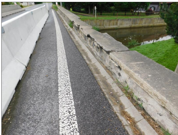
Kamenné parapetní desky mají ураžené hrany, některé jsou hloubkově degradované.
