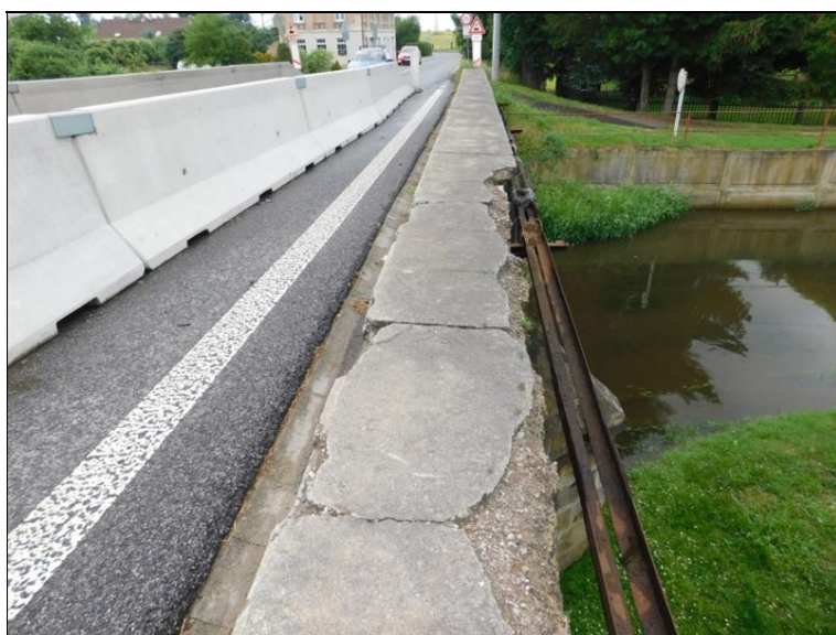
Kamenné parapetní desky mají ураžené hrany, některé jsou hloubkově degradované.
