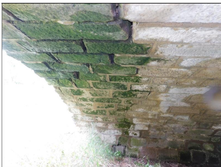
Spodní líc pole 3, levá strana. Podélné trhliny a rozvolněné zdivo klenby v pásu šířky 1,0 m.
