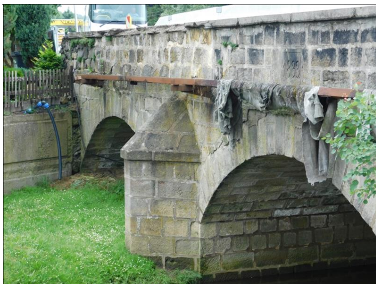
Detail pravého boku pole 2, koroze nosníku inženýrských sítí, zachycené tkaniny.
