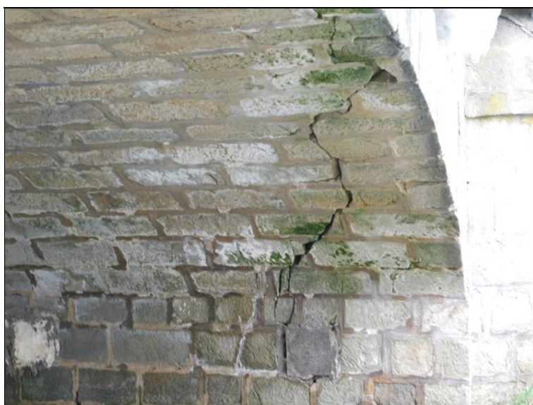
Svislá / podélná trhlina na pravé straně pole 2 a pilíř P3.
