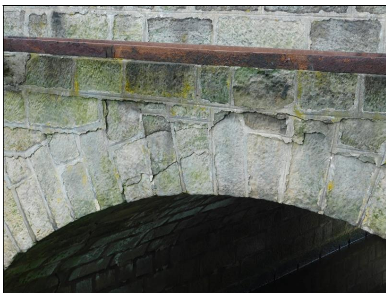
Pravý bok pole 2, vystouplá čelní zeď. Ve spáře mezi nosnou konstrukcí a čelní zdí podélná trhlina.
