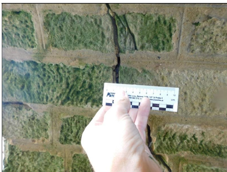
Široká trhlina na pravé straně pilíře P3 ve vzdálenosti cca 1,0 m od pravého kraje, detail šířky 10 mm.
