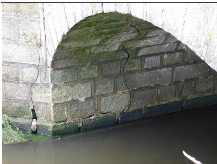
Detail širokých trhlin na líci pilíře P3 a nosné konstrukce v poli 3.
