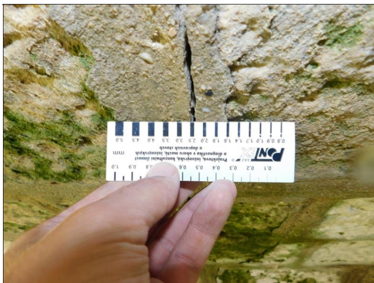
Detail podélné trhliny na spodním líci klenby šířky 2,5 mm.
