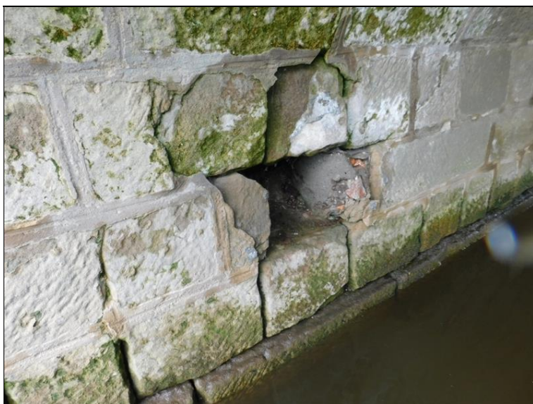
Chybějící kámen v patě opěry OP3.
